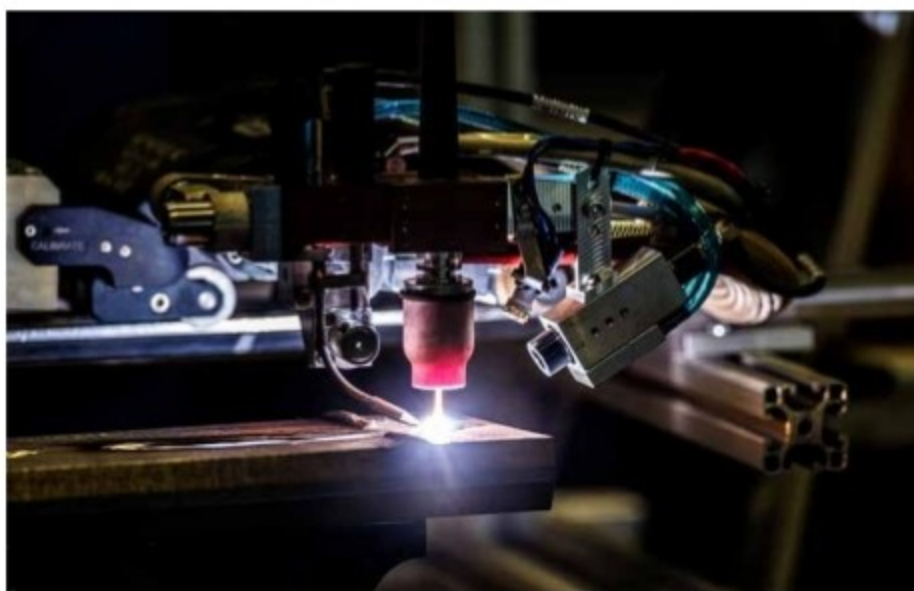
För att reparera tryckkärl och reaktorer används avancerade och fjärrstyrda svetsrobotar.
